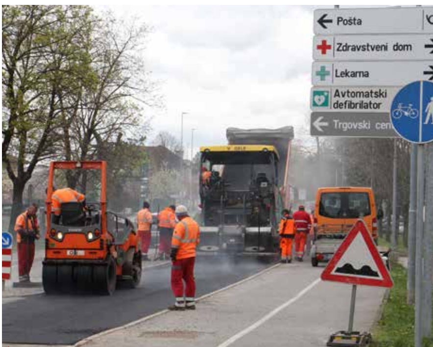
Obnovljeno je bilo vozišče v dolžini 167 metrov.
