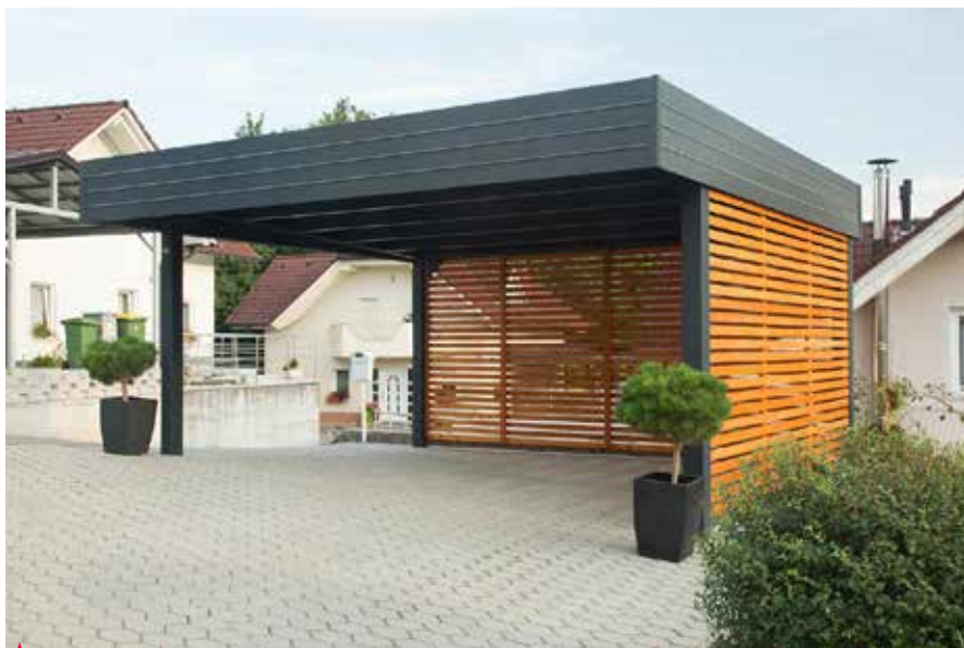
▲ Gradnja nadstrešnice kot enostavnega objekta v velikost do 20 m 2 se lahko začne brez gradbenega dovoljenja.
