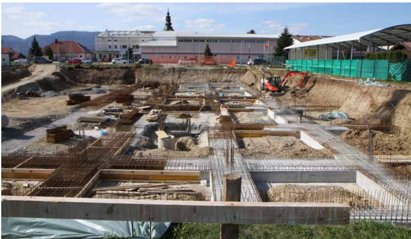
Gradnja stanovanjske zgradbe bo končana jeseni 2024.
