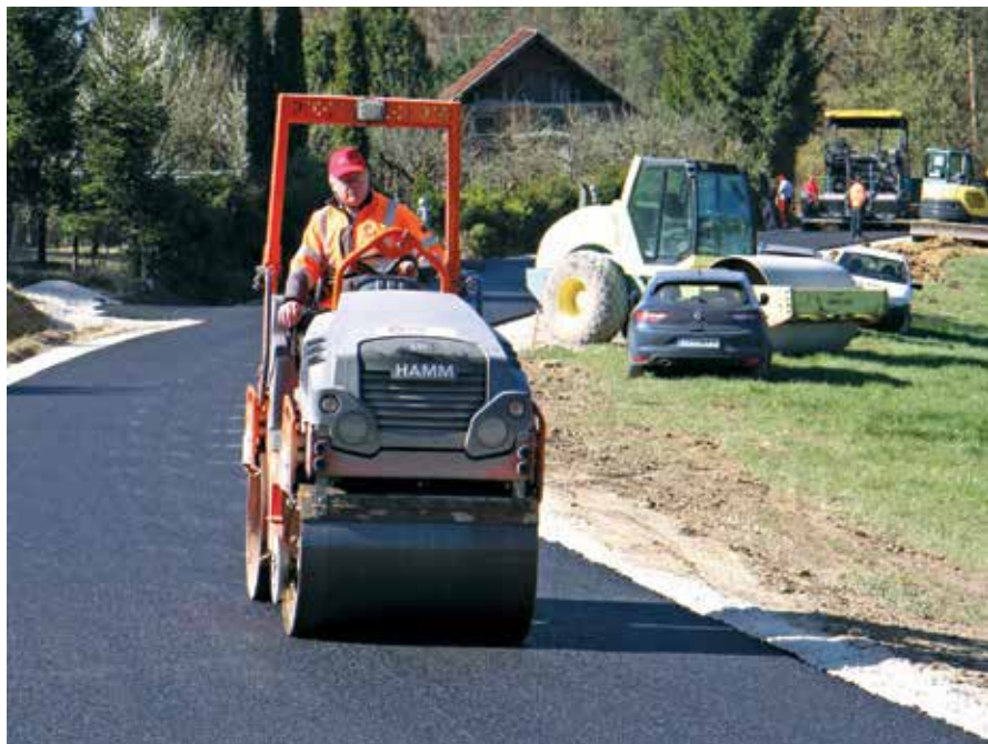
Asfaltiranje ceste je potekalo v začetku aprila.
