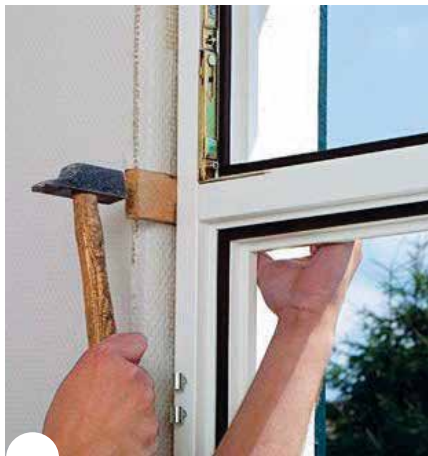
Zamenjava oken je eden izmed ukrepov za zmanjšanje stroškov ogrevanja.
