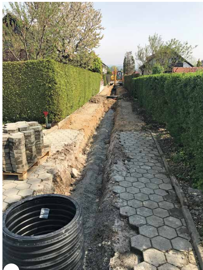
Gradnja bo predvidoma v celoti končana do 1. julija 2017.
