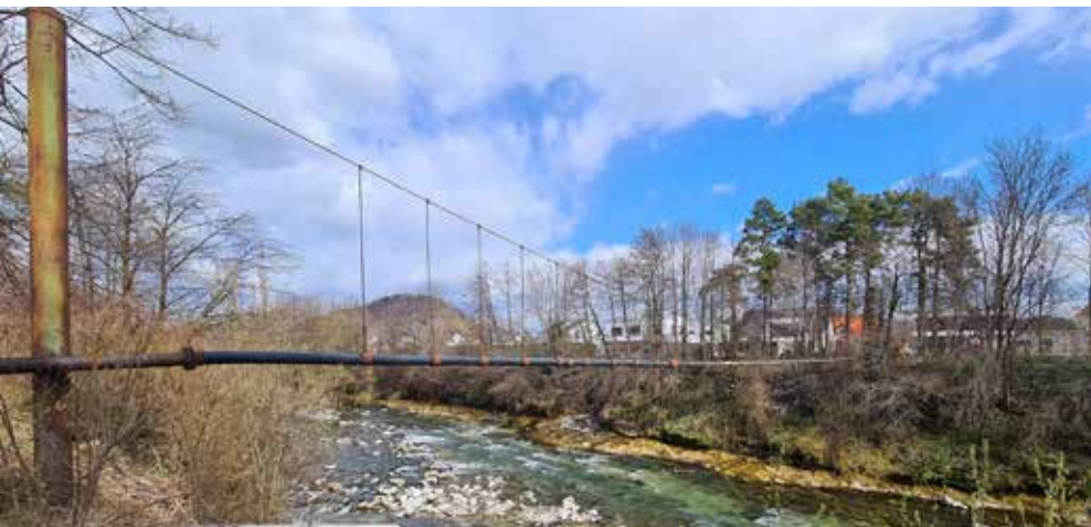
Trasa obnovljenega vodovoda bo potekala pod Savinjo.
