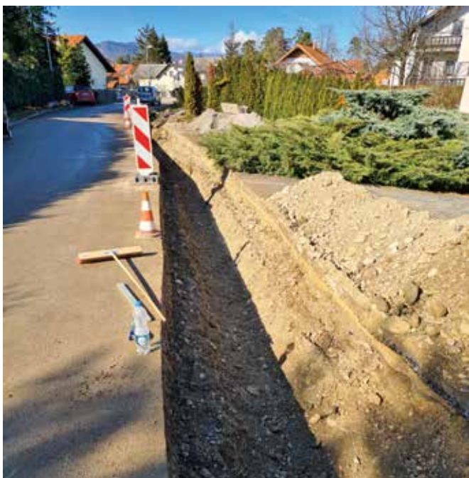
Gradnja pločnika poteka sočasno z gradnjo optičnega tekomunikacijskega omrežja T-2.
