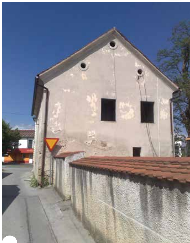
Stavba ob cerkvi na Polzeli, v kateri so bili prostori Občine Polzela ter pošte (med letoma 1918 in 1942). Fotografirano pred rušenjem leta 2010.
