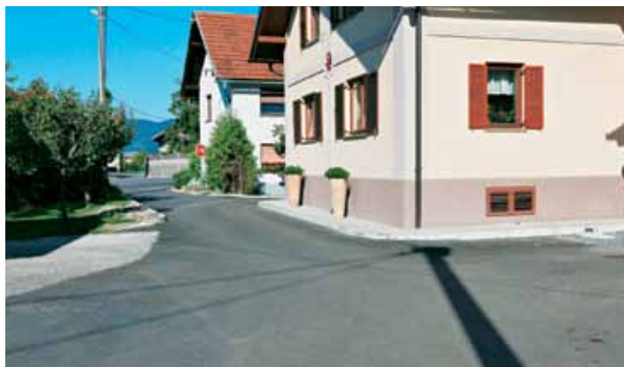
Nova podoba v Ločici po zaključku gradnje kanalizacije
