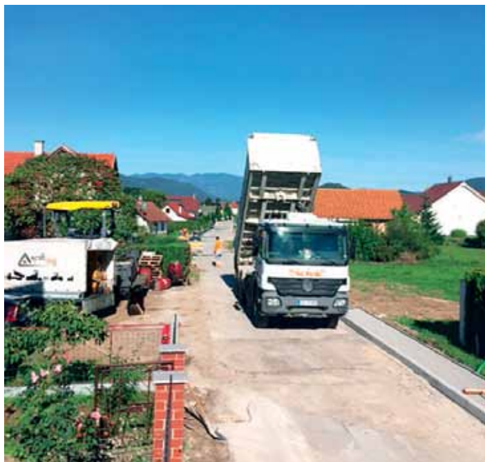
Asfaltiranje cestnega odseka »Kerstein«
