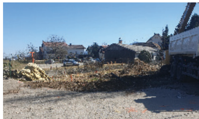
Gradnja se je že pričela in bo trajala predvidoma do konca avgusta 2022.
