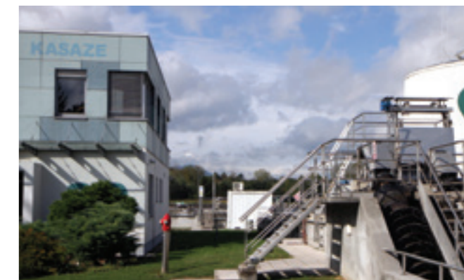
Centralna čistilna naprava Kasaze (CČN Kasaze) je mehansko-biološka čistilna naprava, ki je namenjena čiščenju odpadnih voda Spodnje Savinjske doline.
