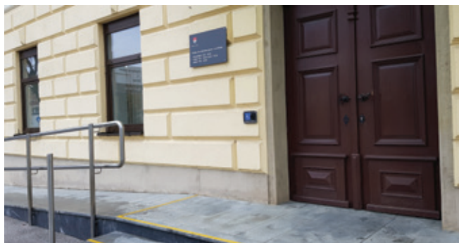
Označene stopnice in zvonec za invalide na občinski stavbi
