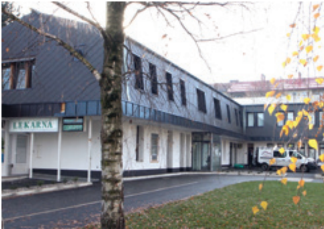
Novourejena okolica odpre pogled na stavbo zdravstvene postaje.
