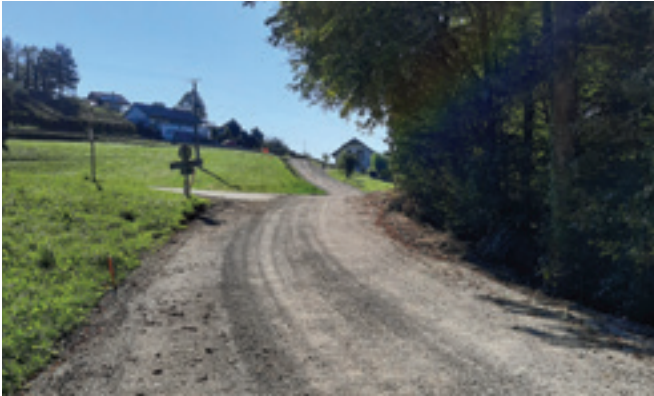
Predvideni konec obnovitvenih del je v oktobru 2023.
