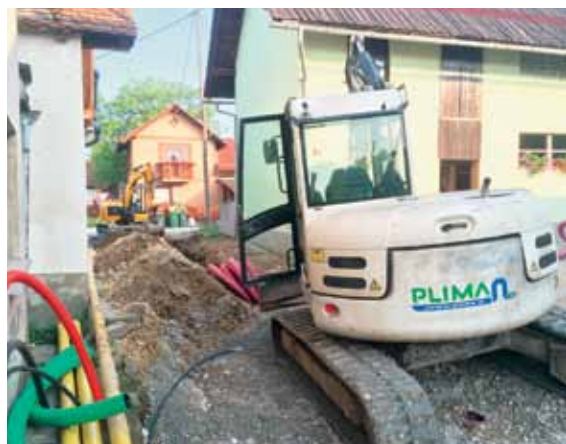
Gradnja kanalizacije na Polzeli
