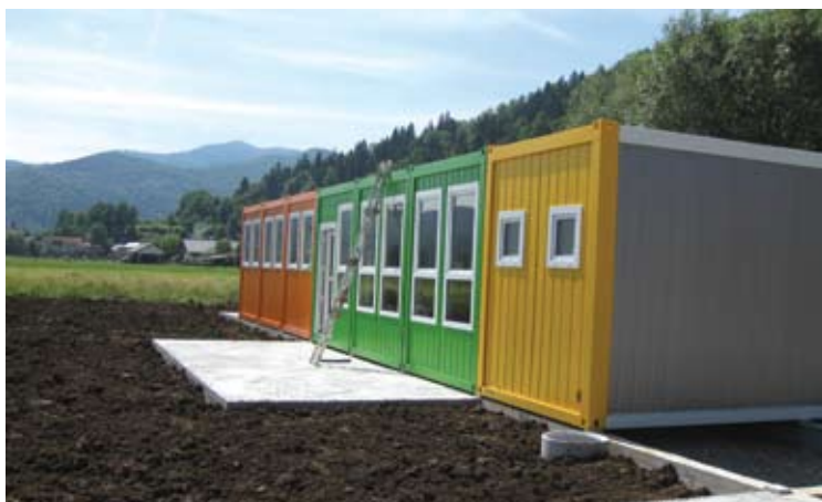
Vrtec Podpeč v fazi postavljanja kontejnerjev
