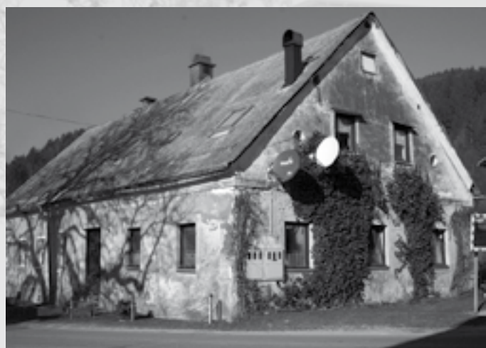
Oničeva hiša pred obnovo
