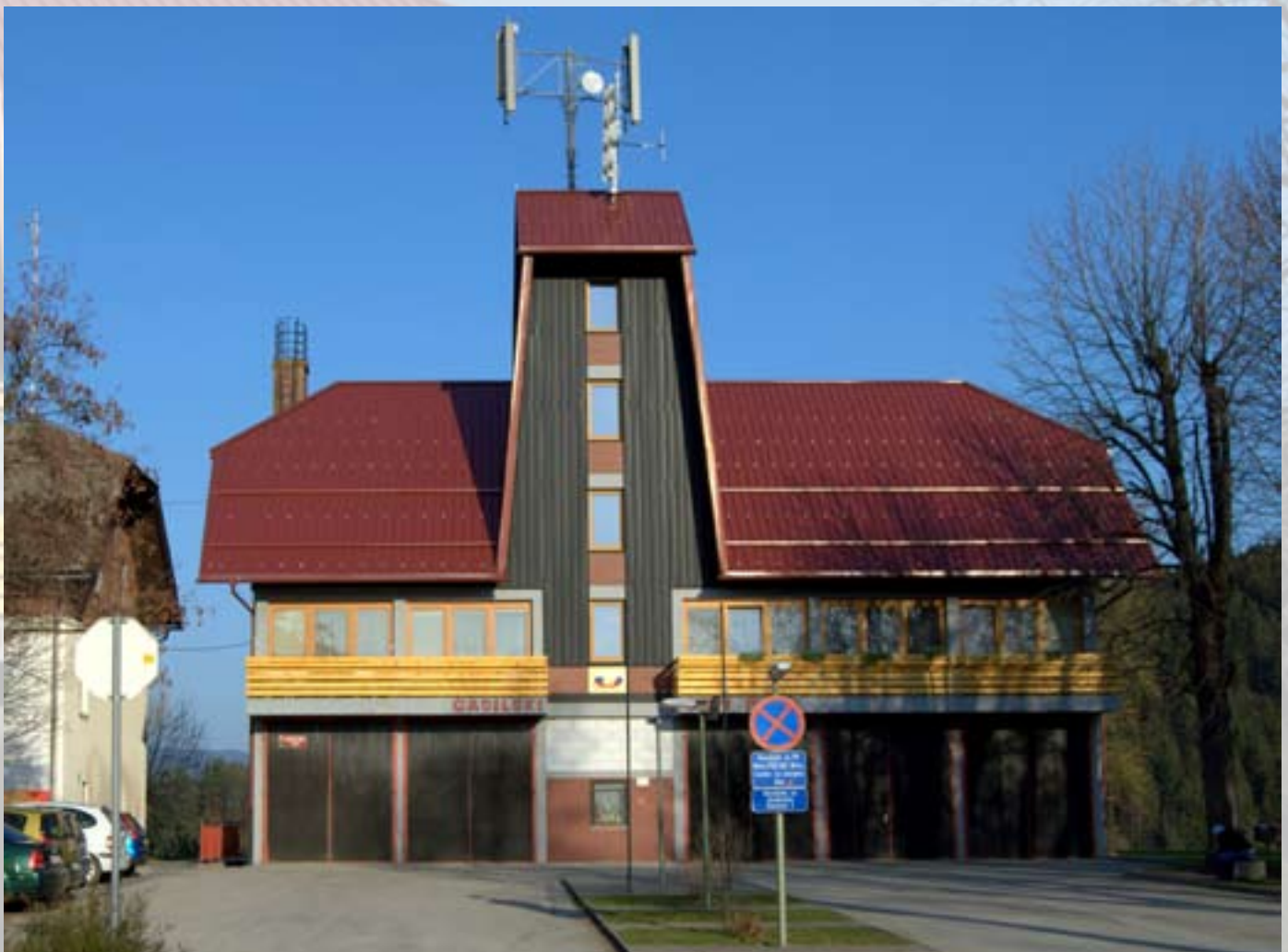
Prenovljen gasilski dom
