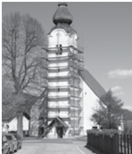
20. april 2015: Začetek obnove zvonika; investicija naša približno 45.000 eur. Srčna hvala vsem, ki ste že prinesli svoj dar.
