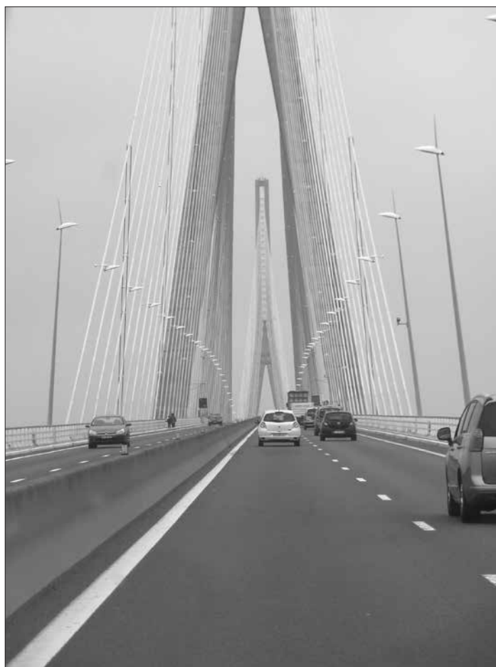
Pont du Normandie
