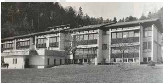
Prvi prizidek k sedanji stavbi (1993)
