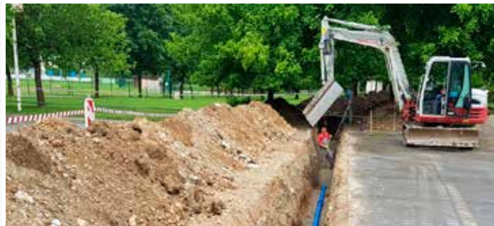
Vzrok za obnovo vodovoda na Šolski ulici je dotrajanost in prilagoditev trase vodovoda načrtovani gradnji Večnamenske športne dvorane Mengeš
