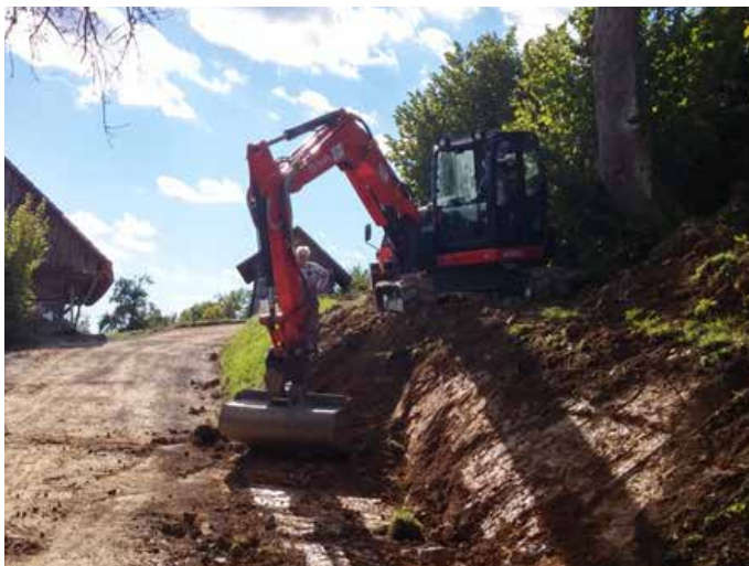
Odstranjevanje brežine in priprava na oporni zid pod hišo Dobeno 6
