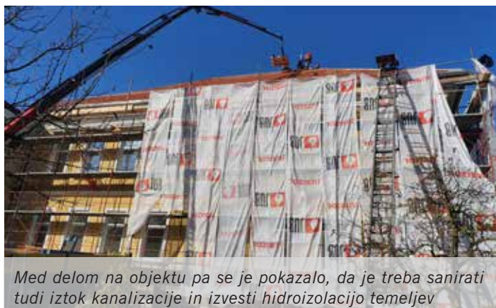
Najprej se je izvedla kompletna sanacija strehe, napušča in delov fasade na mestih, kjer se je luščil omet
