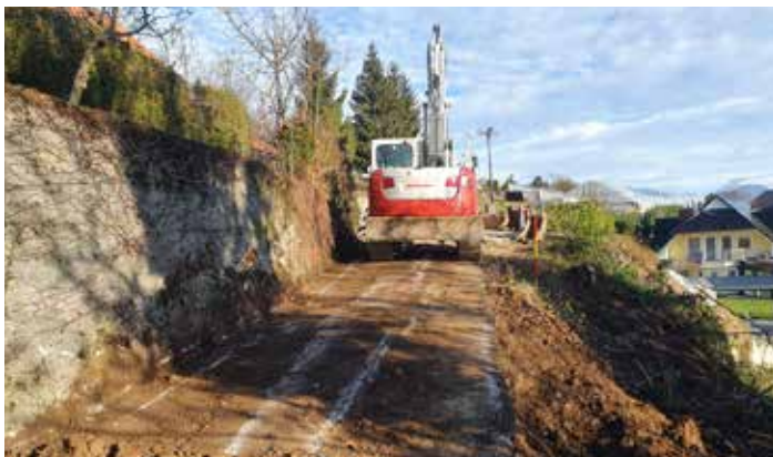
Na celotnem odseku je potreben izkop trde kamnine oziroma uporaba pnevmatskega kladiva za razbijanje skal
