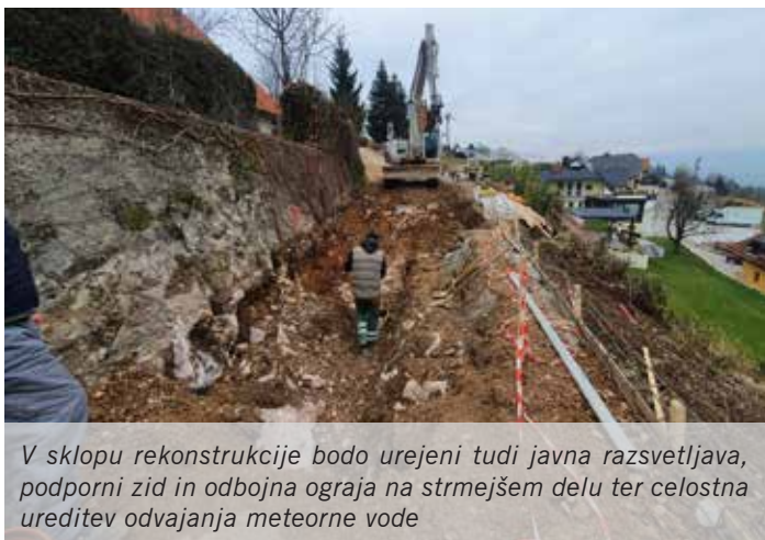
Na celotnem odseku je potreben izkop trde kamnine oziroma uporaba pnevmatskega kladiva za razbijanje skal
