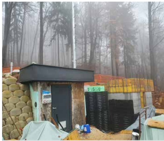
Na prenovljenem in razširjenem vodohranu Dobeno bo zagotovljeno 100 m 3 rezervoarskih kapacitet, vzpostavljen pa bo tudi sistem daljinskega vodenja
