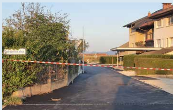
Investicija se je zaključila konec meseca julija z novo asfaltno prevleko po celotni širini ceste.
