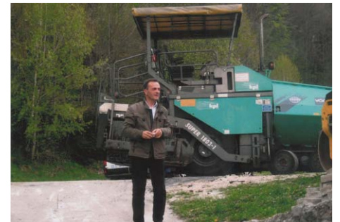
Tomaž Cerar je nadzoroval polaganje asfalta
