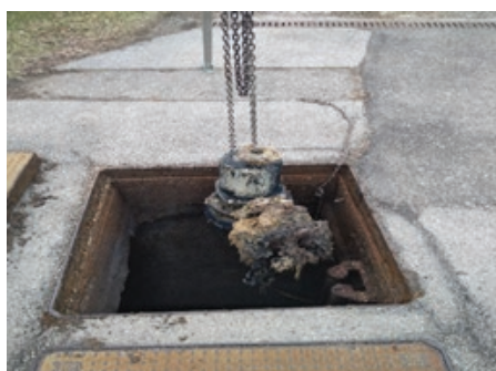
Črpališče Kungota – ročno odstranjevanje odpadkov iz črpalke
