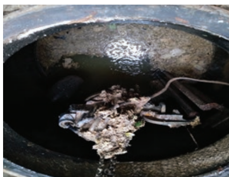
Črpališče (vakumsko) Jablana – ročno odstranjevanje odpadkov
