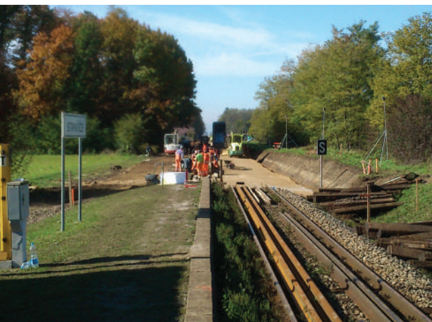
Urejaje spodnje plasti drobnega gramoza. Proga dobiva novo podobo.
