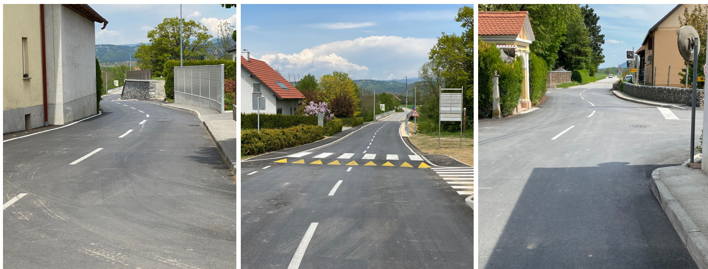
Rekonstrukcija odseka občinske ceste v naselju Šešče
