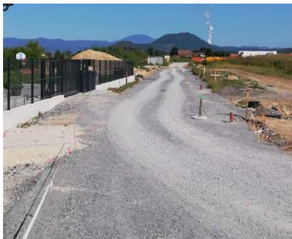
Končana izgradnja vodovoda in kanalizacije
