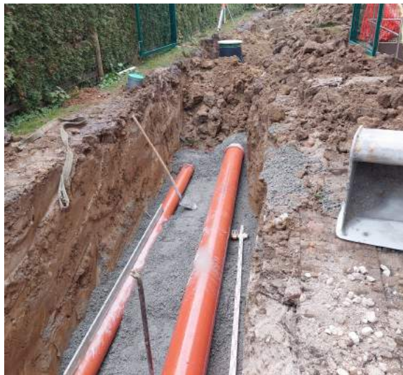
Rekonstrukcija odseka kanalizacije na Prečni poti
