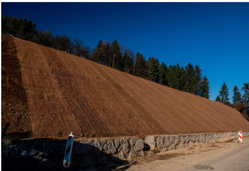
Sanacija in stanje po sanaciji plazov v Matkah
