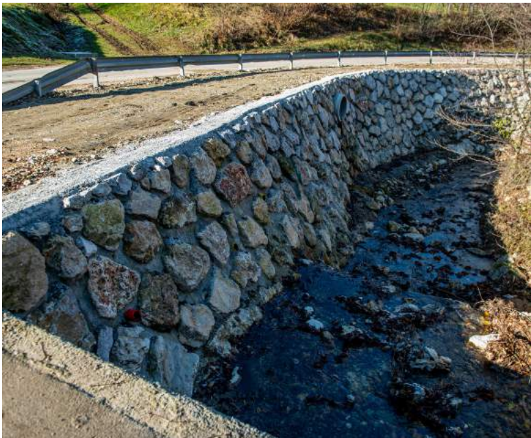
Sanacija brežine potoka Kolja v Matkah
