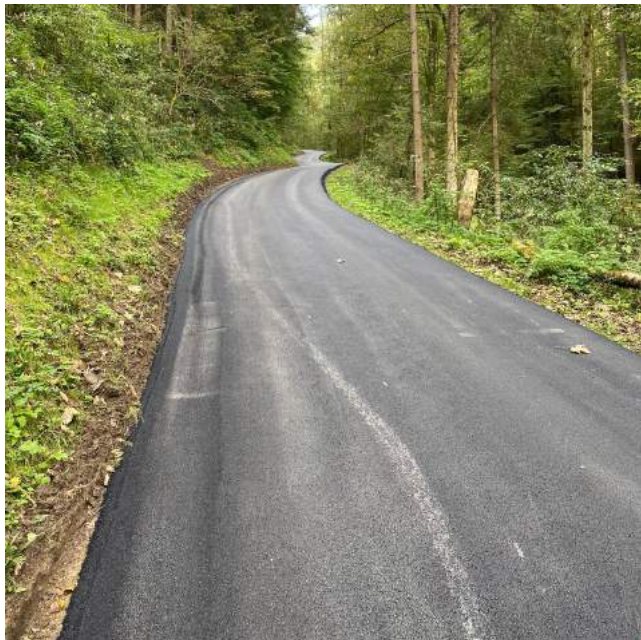
Sanacija enega izmed treh poškodovanih odsekov
