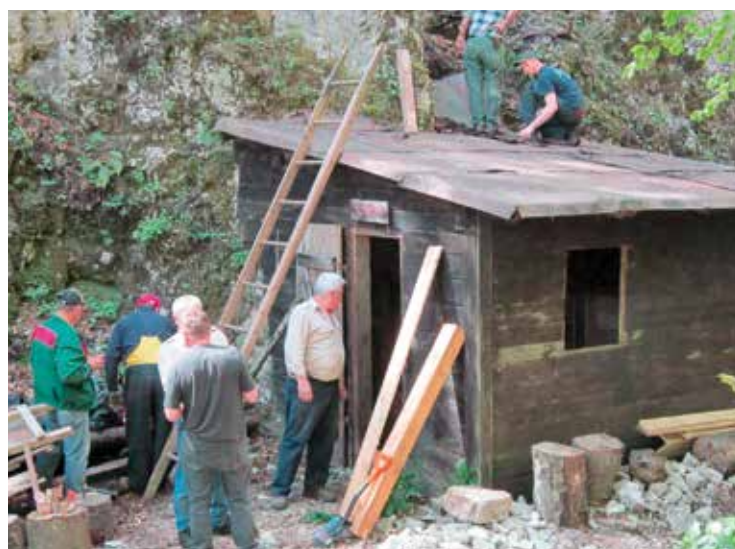
Obnovitvena dela na objektih
