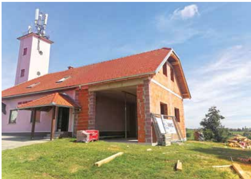
Gradnja garaže za gasilsko vozilo
