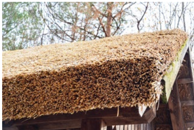
Obnovljena streha na počivališču Cankovec v Panovcih, foto Stanka Dešnik
