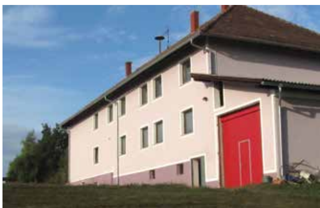
Obnova vaško - gasilskega doma v Ženavljah
