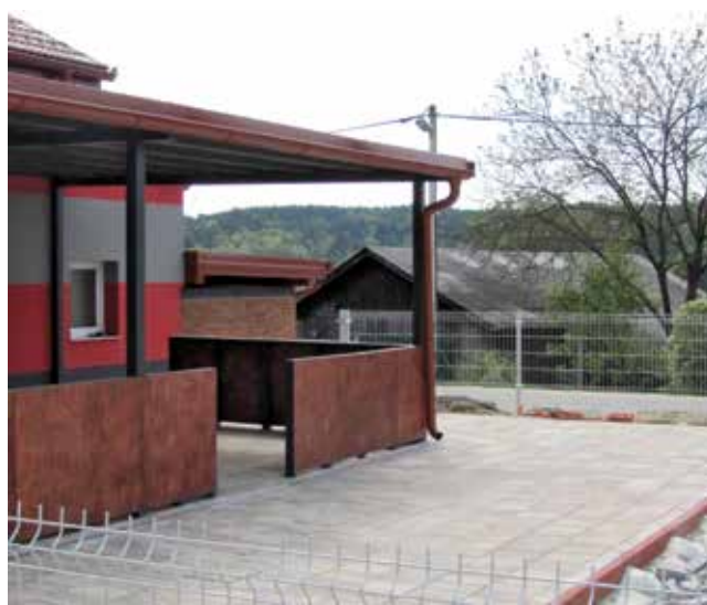
Ureditev nadstreška in ograje pri vaško - gasilskem domu v Šulincih
