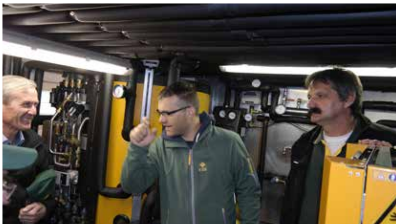
Predstavitve referenčne kotlovnice na ekološki kmetiji Kerčmar - Abraham
