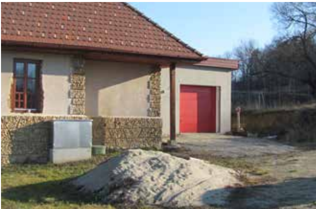
Vaško - gasilski dom v Adrijancih - v gradnji
