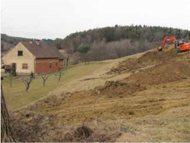
Plaz nad hišo Horvatovih v Boreči
