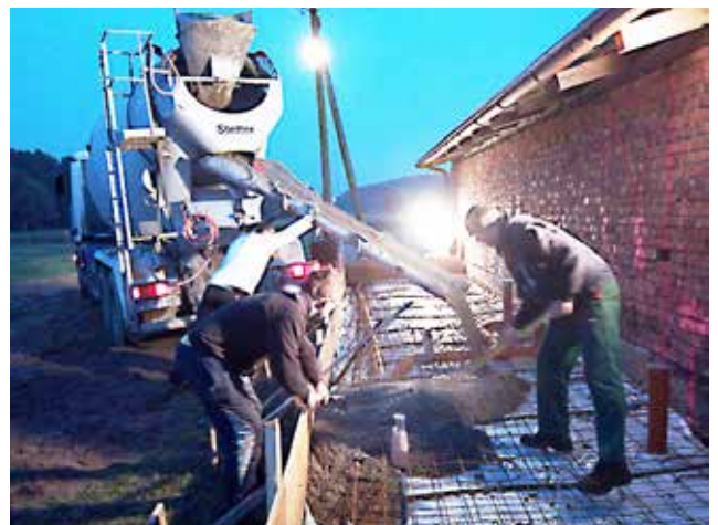
Gradnja novih sanitarij pri klubski hiši
