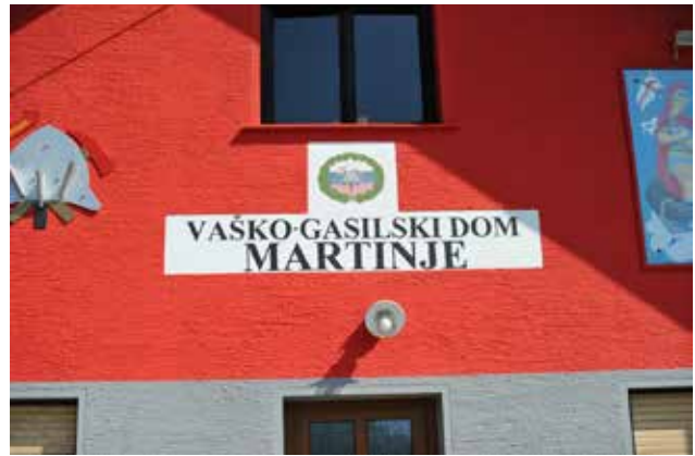
Prenovljeni vaško - gasilski dom v Martinju
