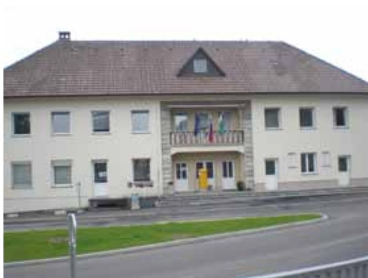
Nova podoba stavbe KD Podpeč
