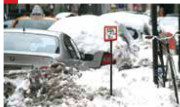
Primer nedostopnega hidranta - samo po oznaki lahko vidimo, da je tu hidrant.
