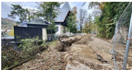
Dela na Cesti svobode, foto: Občina Bled
