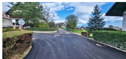
Položen grobi asfalt v Zasipu, Ledina, vir: Občina Bled
