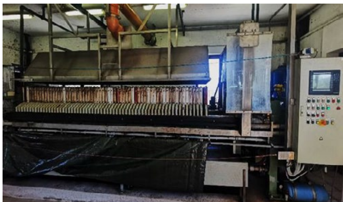
Foto KSD: Naprava za dehidracijo blata na CCN Ajdovščina
