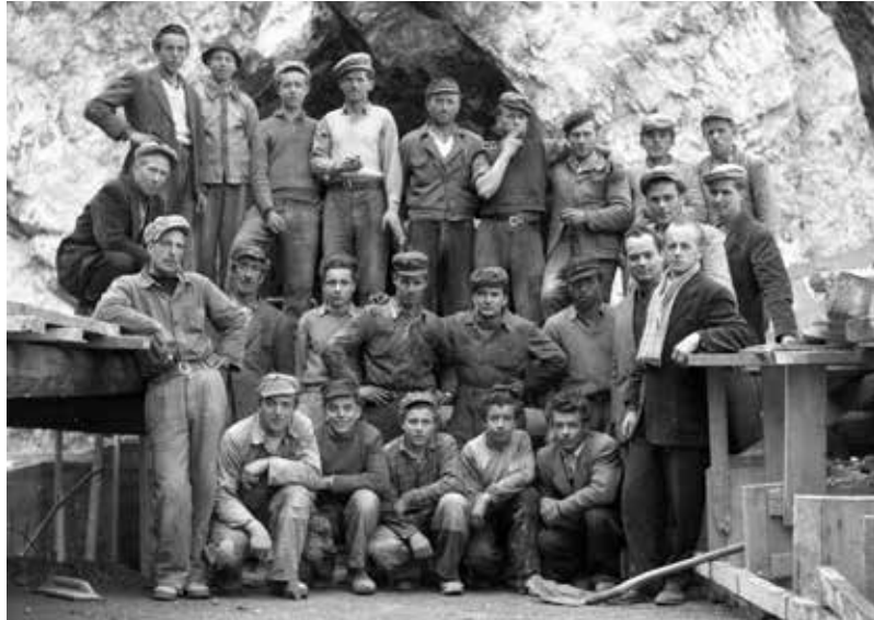
Delavci in vodje ob koncu betoniranja leta 1955. Foto Ivan Kramžar, arhiv MNSZS
