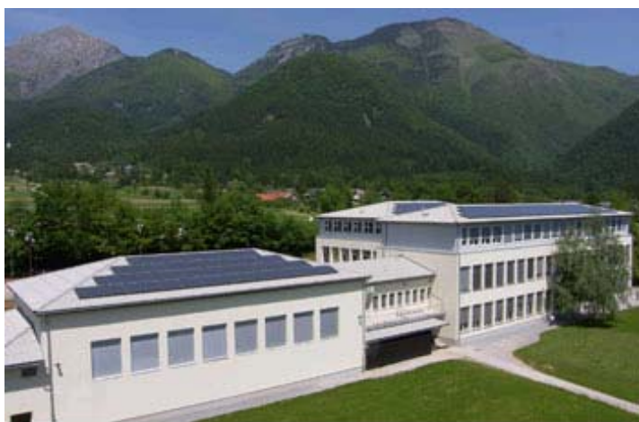
Slika 15: Sončna elektrarna na strehi OŠ Preddvor (Vir: Gorenjske elektrarne)
