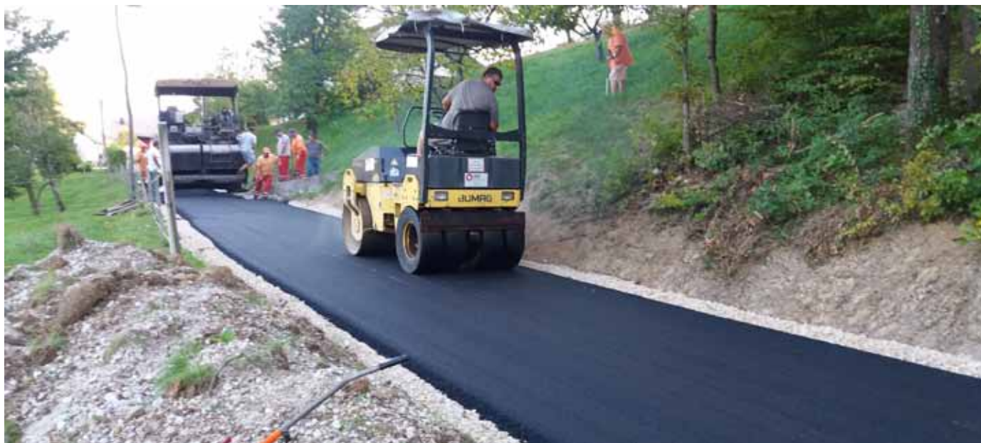
Asfaltiranje ceste v Bezenškovo Bukovje
