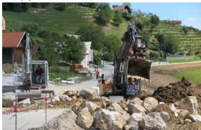
Sanacija plazu in obnova lokalne ceste
