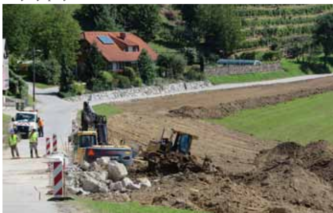
Izvajanje projekta na terenu
