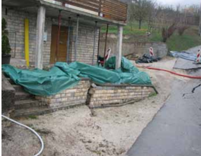
Pri gradnji objektov je temeljenje eden prvih gradbenih posegov.
