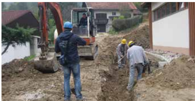
Izgradnja prireditvenega paviljona
