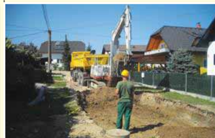
○ Sv. Trojica je veliko gradbišče
