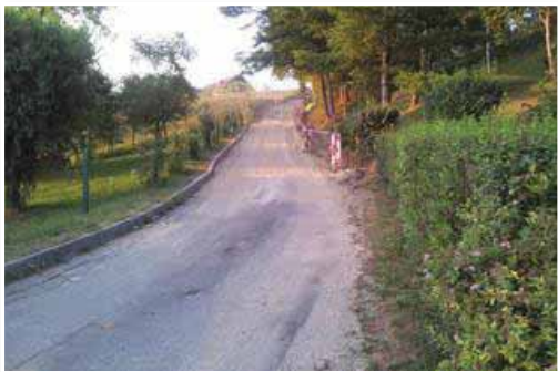
»Na Lešnikovem klanecu so dela za rekonstrukcijo ceste že stekla.«
