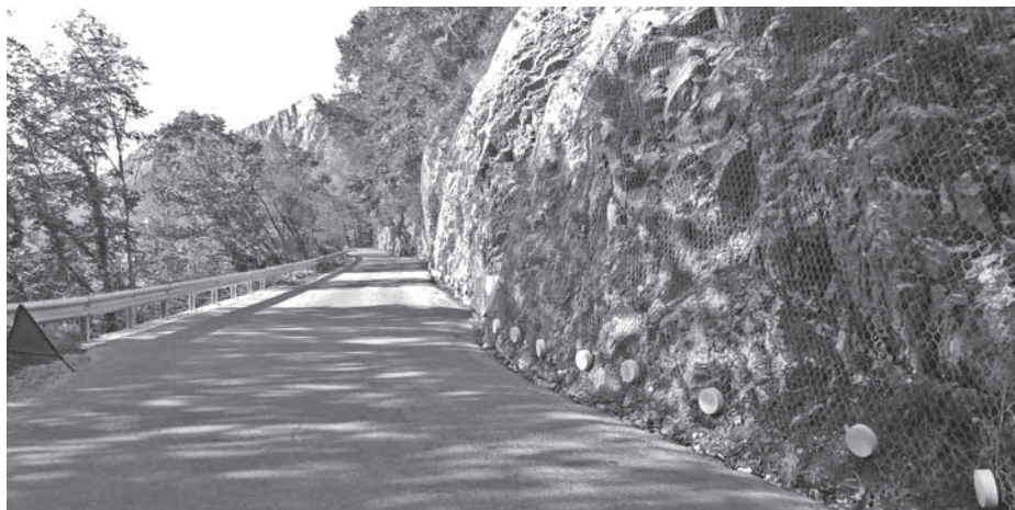
Saniran odsek lokalne ceste Kobarid–Drežnica.
