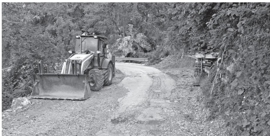
Lokalna cesta Vrsno–Krn v času sanacije.
