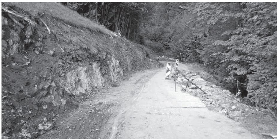
Sanacija usada Jevšček na odseku ceste Jevšček–Piki.
