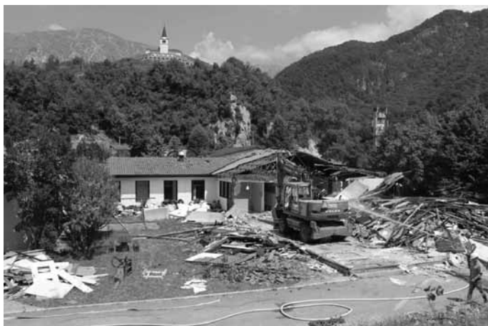
Gradbena dela na objektu vrtca v Kobaridu so se že začela. Foto: arhiv Občine Kobarid
